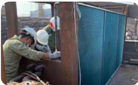
نصب کندانسورهای بومی سازی شده پکیج اتاق برق احیا
