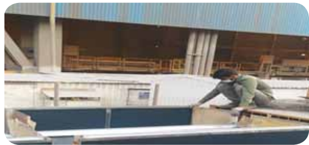
نصب کندانسورهای بومی سازی شده چیلر فولادسازی
